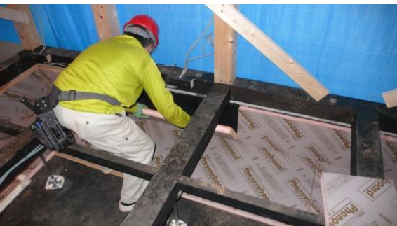
断熱材を貼付します。
