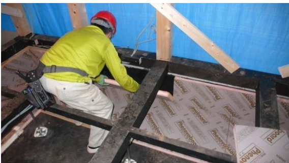
断熱材を貼付します。
