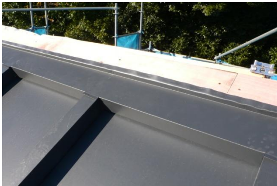
ガラス押え部材取り付けのための下地工事が完了したところです。
