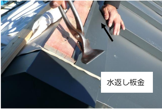
水返しのための板金設置状況。
