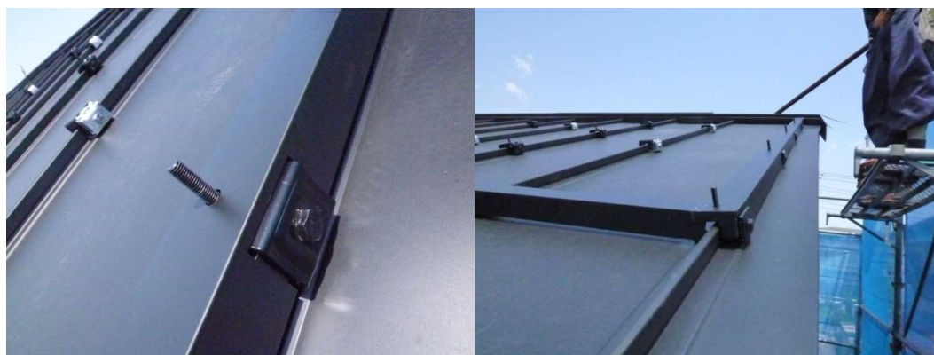
東側 ケラバ金物カバー取付状況
