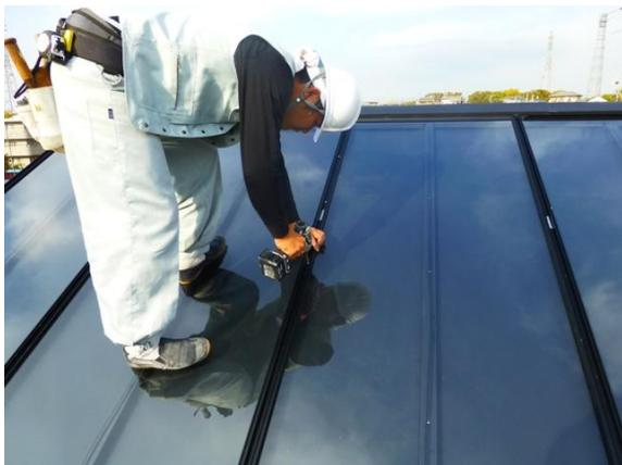
ビス取り付け前にφ3mm以下の金属用ドリル刃で下穴を開けます。
