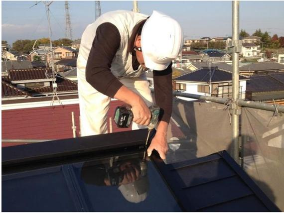
側部押え金物フタをスライドさせ固定した後、道穴を開け、ビス止めします。
