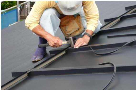
ガラスの中央となる瓦棒芯木に一文字型のクッション材を、25mmのステンレススクリーニングで止めていきます。クッション材は上端下端とも50～100mm程度逃げたところから敷き始めてください。スクリーニングのピッチは、300～400mmとしてください。なお、スクリーニングはクッション材中央の溝の中にしっかり打ちこんでください。（釘の頭が出ていると強化ガラスを破損させる原因となりますので、ご注意ください）
