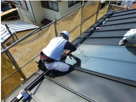
端部パッキンを付けたガラスを水下の下端押えアングルに合わせて並べていきます。
