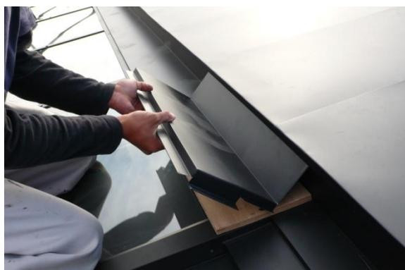
木下地に板金製の雨押え役物を取り付けていきます。
