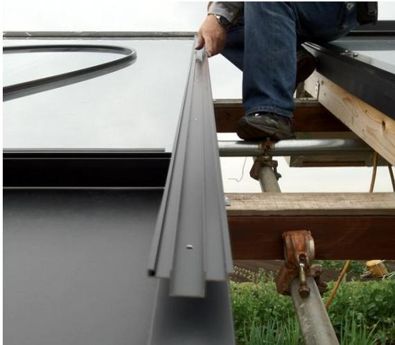
側部押え金物は、水上下端の向きがあるので、注意して取り付けします。
