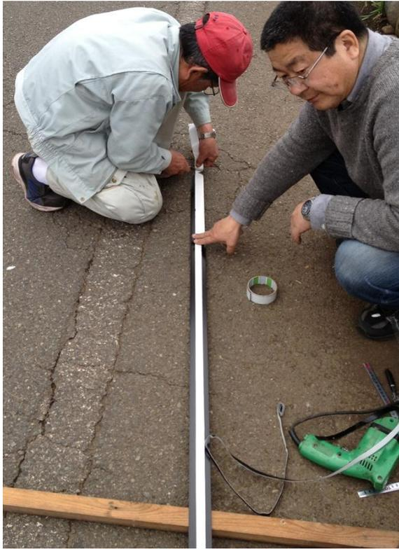
側部押え金物の接地面に両面接着の防水テープを貼ります。
