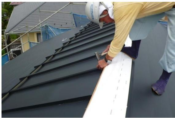
芯木の上下両端と50cm程度の間隔でクッション材を釘で打ち付けます。
