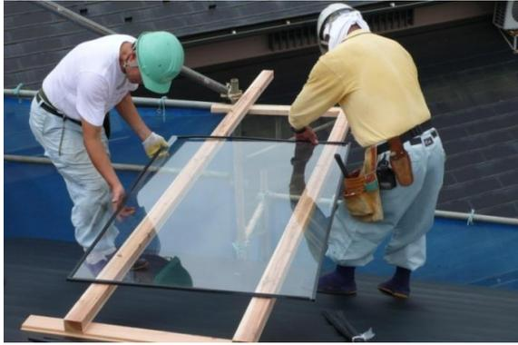
端部パッキンは、流れ(長辺)方向をガラス両端まで伸ばして取り付けます。
