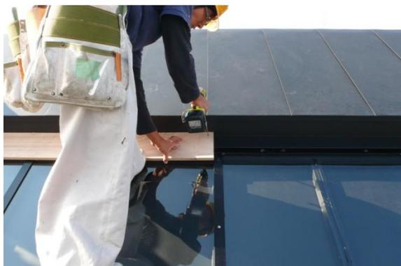
最後に水上側に板金役物を取り付けてガラス式集熱面は完成します。片流れ屋根の場合は雨押え水切り、切妻の場合は、棟覆い（棟合羽）水切りとなります。
