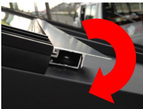
下端ガラス押え金物のフタを取り付けます。
