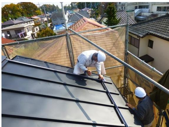
ガラスの滑り落下を防ぐための、下端の押え金物を取り付けます。
