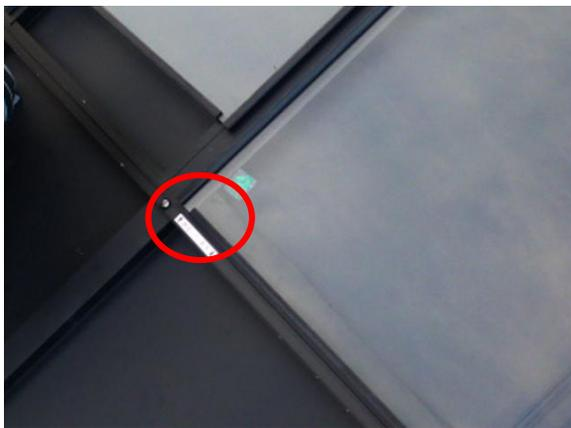
ガラスを仮置きしたら側部ガラス押え金物を仮置きします。
