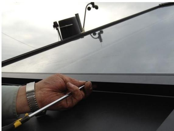
ネジ止めして、下端押え金物のフタを固定します。
