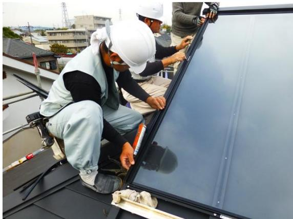
全てのガラスの間にT字型のガラス押え金物を仮置きした後、ガラスのクリアランスを調整します。
