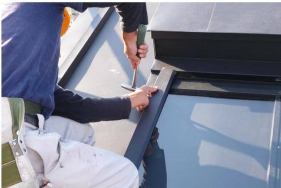
端部パッキン脱落防止とガラス下面への雨水の浸入を防ぐため、ガラス集熱面の両ケラバ側にアンクル状の板金役物を取り付けます。
