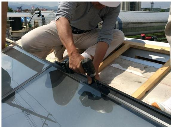
棟部品Ⅱ型（金物）を集熱パネル水上部分に取り付けます。
