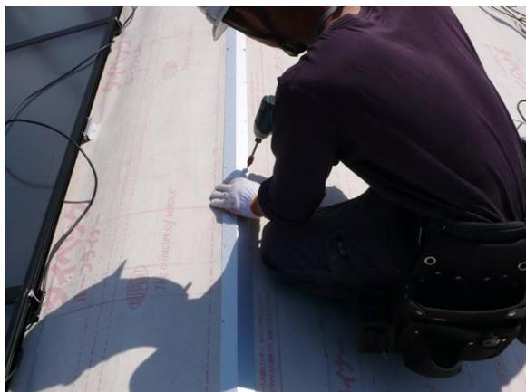
ルーフィングの保護のため、棟シール板を取り付けます。取り付けに当たっては、野地板にビスを効かせるため、全ネジのコーススレッドをご使用下さい。
