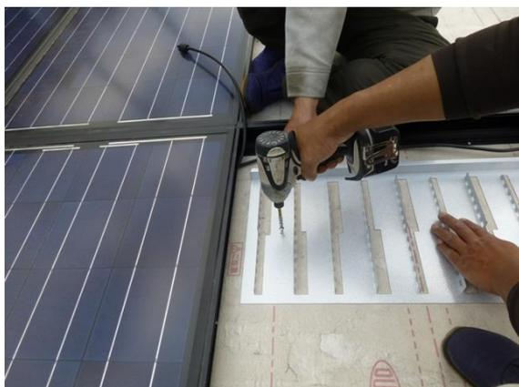
採熱板を取り付ける際は、ビス穴のルーフィング接触部分に両面の防水プチルテープを貼付して下さい。
