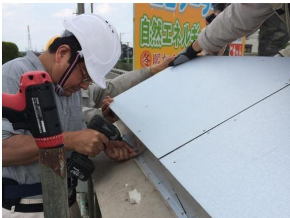
頭ツナギに集熱チャンバーを押し付けながら、ビス止めします。
