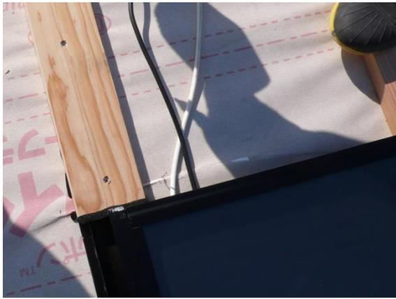
ケラバ側の90×30mmの木材は、アルミ棧の小口と芯合わせでしっかりと押しつけて設置します。
