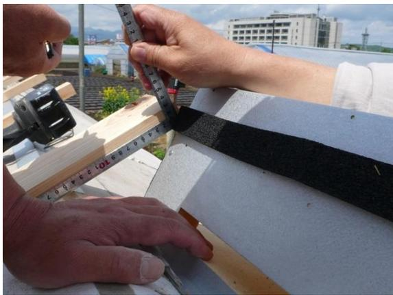
頭ツナギを取り付けるための、通気タルキの寸法を出します。
