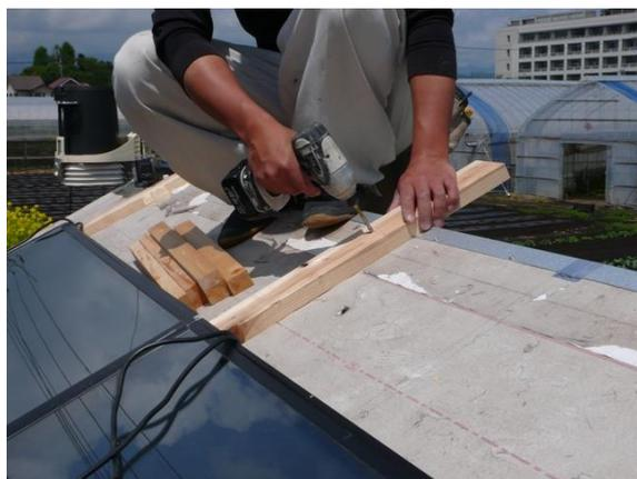
下図のレイアウトで通気タルキ90×30、40×30を取り付けます。
