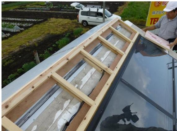
納まり図に基づいてフェノールフォーム系断熱材（ネオマフォーム、フェノバボード等）を敷き込む下地を作ります。
