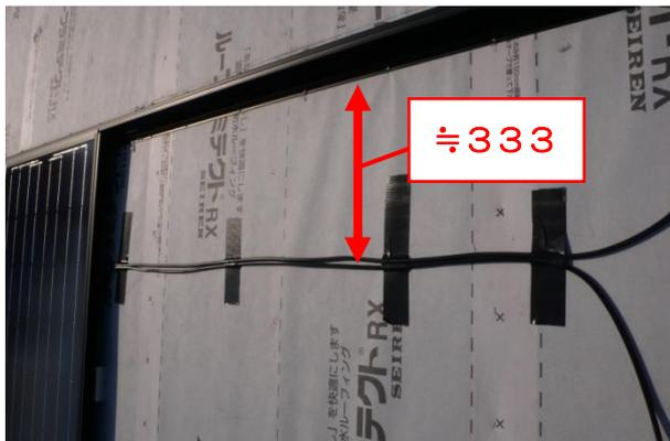
採熱板の割付図の配線スペースにケーブルをテープでしっかり固定します。
