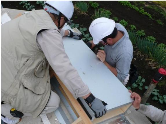
頭ツナギを取り付けたら、集熱チャンバーを取り付けます。
