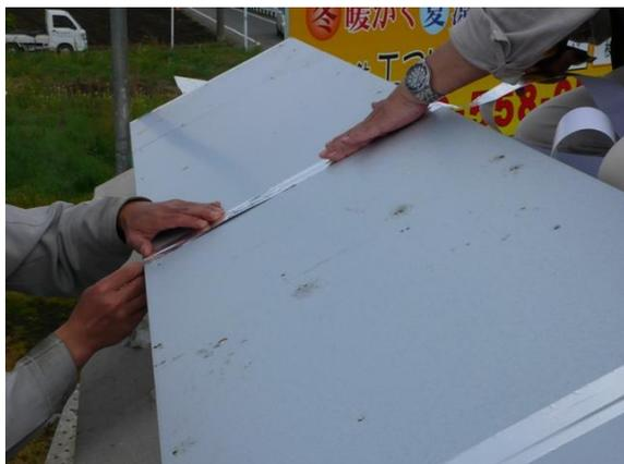
集熱チャンバー同士の接続部には、アルミテープをかけて気密を確保します。
