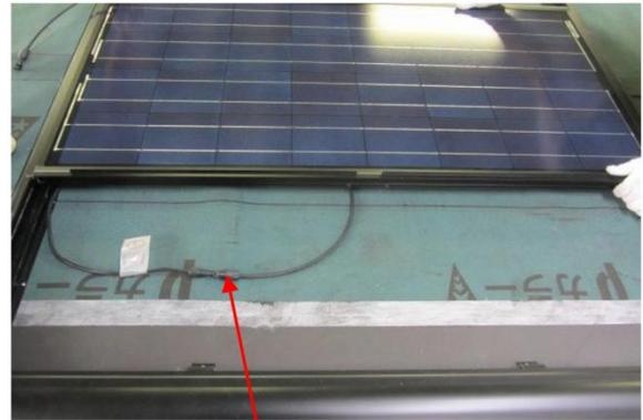
1枚目のモジュールのケーブルと室内へ取り込む引込ケーブルのコネクタをカチッと音がするまで差し込みますコネクタの連結を忘れると発電しませんのでご注意ください。
