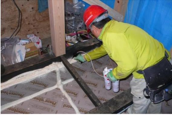
発泡系の断熱材で隙間を埋めます。
