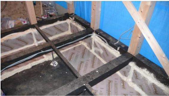
基礎断熱の設置が完了します。
